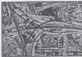
匝道出入口顺序不对
