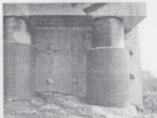
桥墩底部包裹钢管, 上部包裹碳纤维
