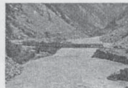
抢通后的彻底关临时钢桥
