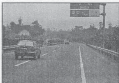
房屋及绿化影响视距,凹曲线底部排水不畅
