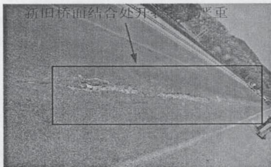
新旧桥面结处开裂破损
