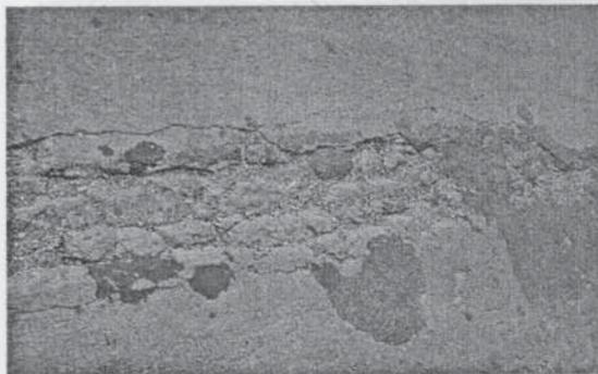
空心板梁绞缝处破损
