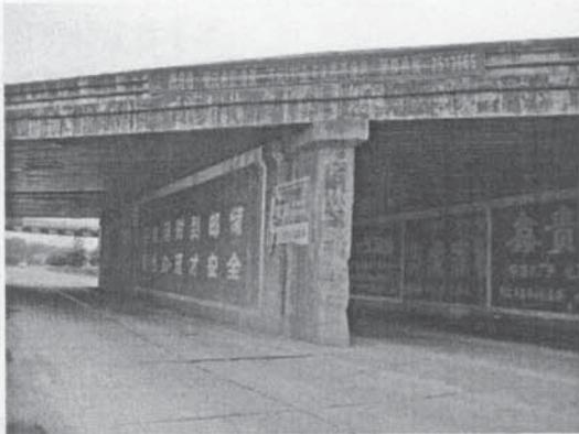
图为即将进行扩宽施工的赤东湖中桥,我们可以清晰看到薄壁桥墩上被来往车辆碰撞的痕迹。
