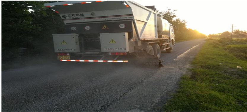
图3 橡胶沥青同步碎石施工现场
