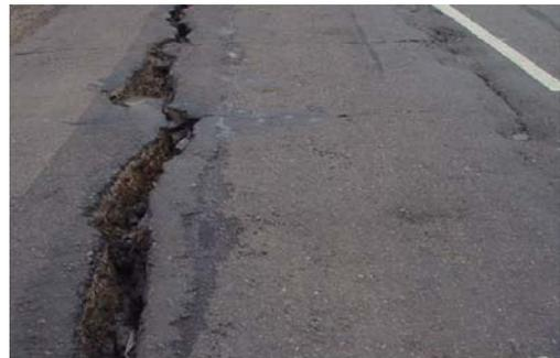
国内某条刚刚完成扩宽施工的高速公路，因新扩宽部分存在软基，且处置不当，施工过程中控制不严，在通车运行不到一年，就发生了严重的纵向裂缝现象，并局部垮塌。
