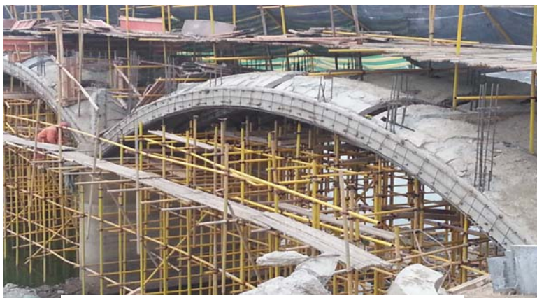
图五 拱肋、立柱加固钢筋
