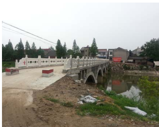
图七 加固维修后的金城桥
