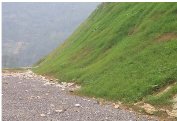
图 22 挖方边坡植物防护
