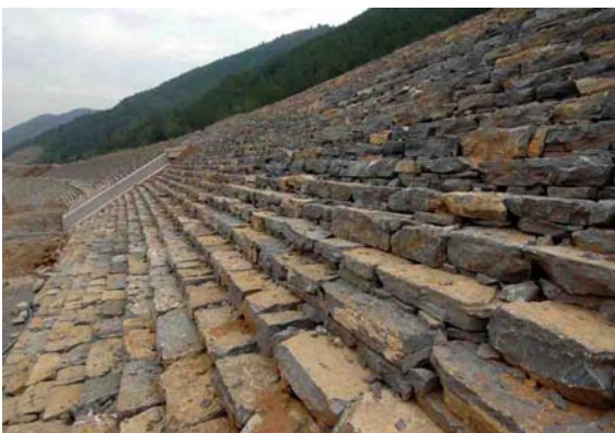
图 12 利用开挖的碎石码砌边坡
