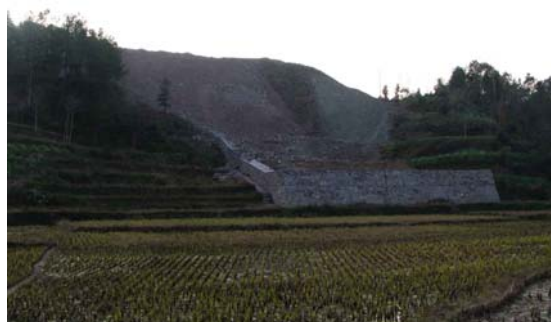
图 42 做好弃渣场防护与排水
