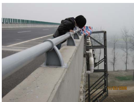
岳口汉江二桥径流收集装置 1
