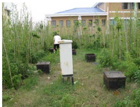
天门西收费站污水处理装置（处理量 8T/h）
