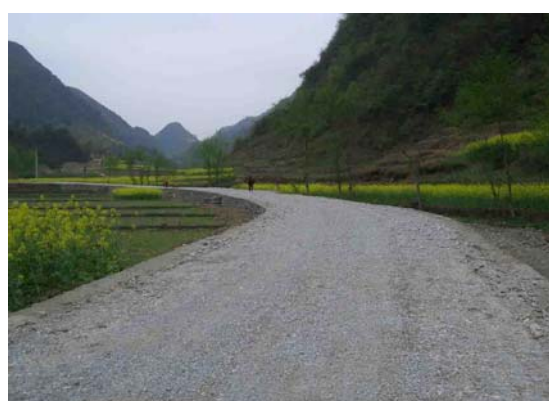
图 40 施工便道成为乡村道路
