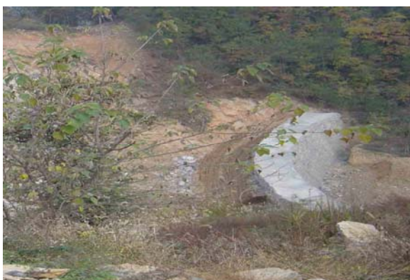
图 41 弃渣场先挡后弃
