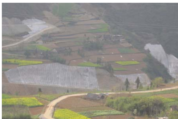
图 25 施工便道边坡植草
