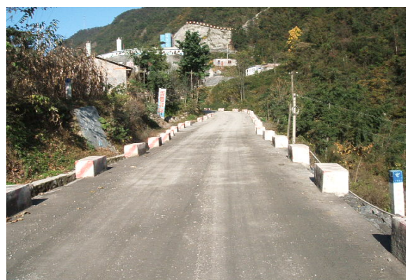
图 39 施工便道建设结合乡村路网改造
