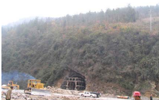
图 13 隧道零开挖进洞
