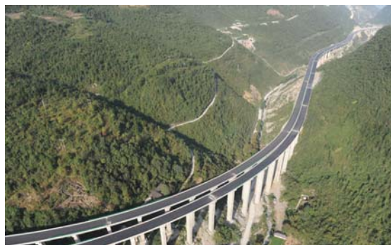
图 14 采用桥梁避免大开挖
