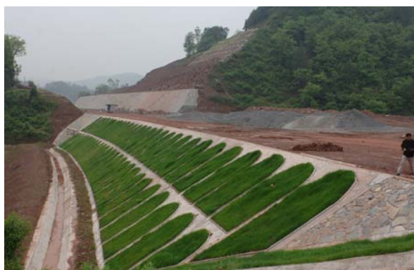
图 27 边坡绿化防护
