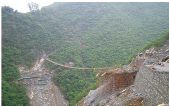
图 24 施工中最大限度的保护地表植被和自然山体斥资百万修建的施工便桥
