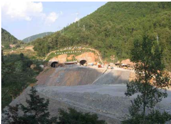
图 11 利用洞渣填筑路基
