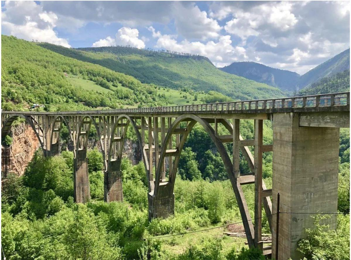
拉锁结构包括斜拉桥、悬索桥和系杆拱桥。拱桥按照受力情况学术上又细分为上承式、下承式和中承式。
