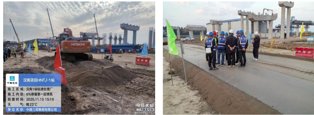
图 1 “砂化法”改良钻渣填筑现场试验
